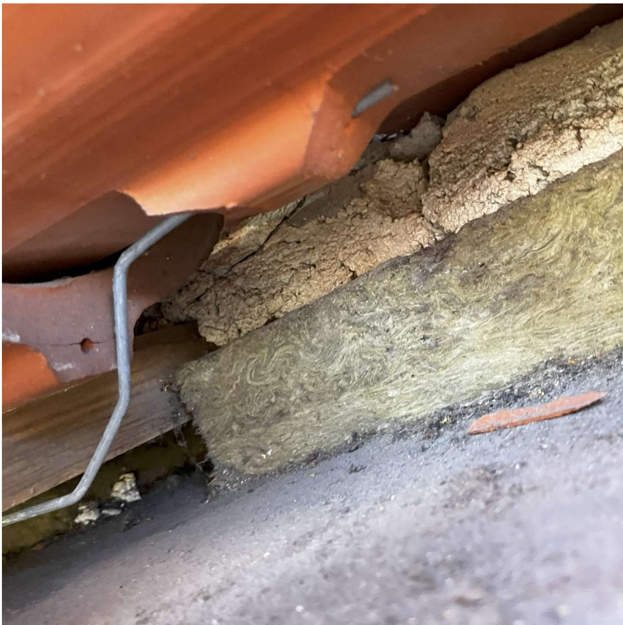
Brandsektionsvæg afsluttet med mineraluldsisolering, placeret mellem lægterne, og fastgjort til undersiden af yderste tagdækning med mørtelpude; brandmæssig adskillelse mellem Annebergvej 3 og 5
