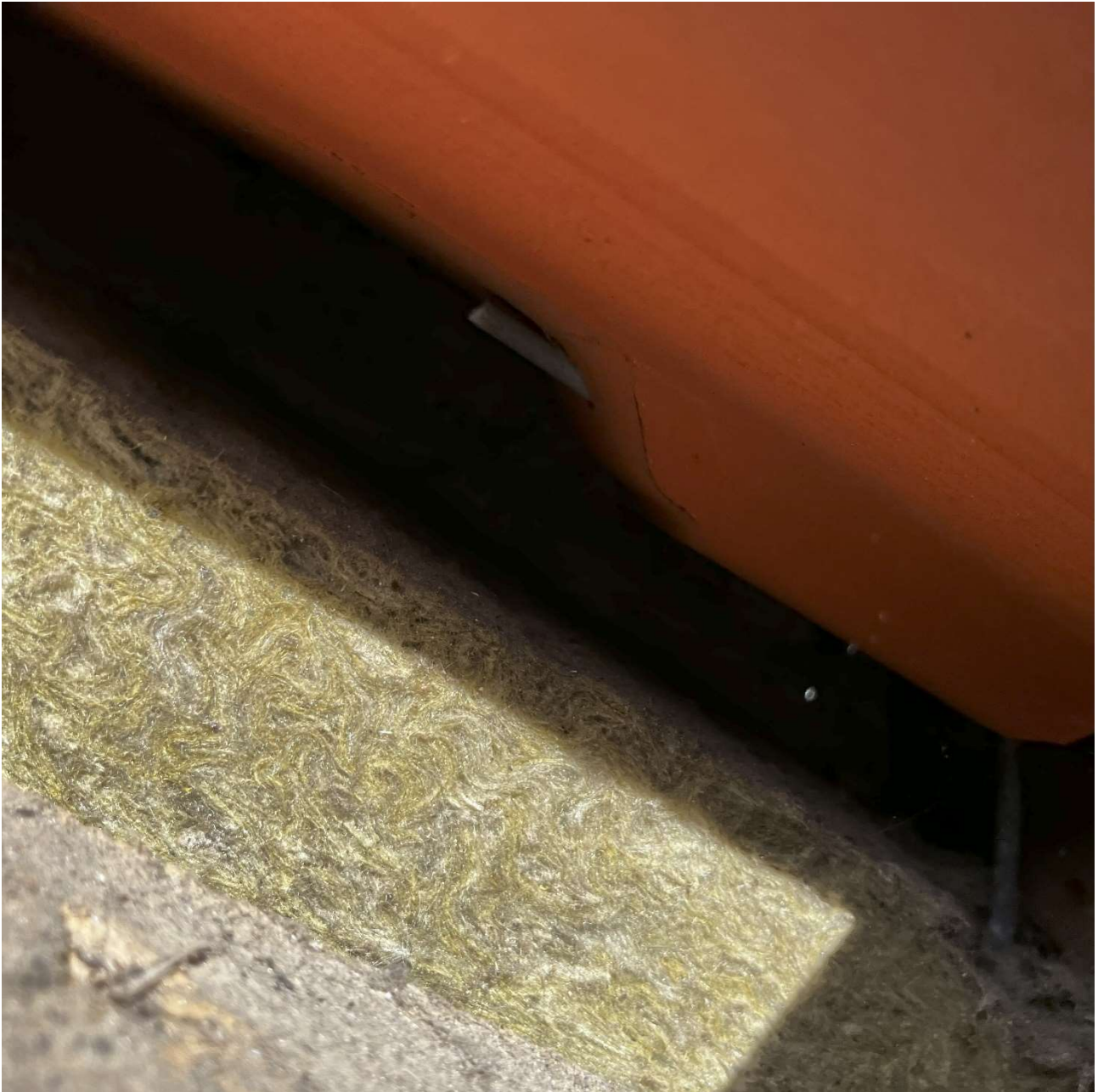
Brandkamserstatning i 1 meters afstand fra brandsektionsadskillelse afsluttet med mineraluldsisolering, placeret mellem taglæggerne; brandmæssig adskillelse mellem Annebergvej 3 og 5
