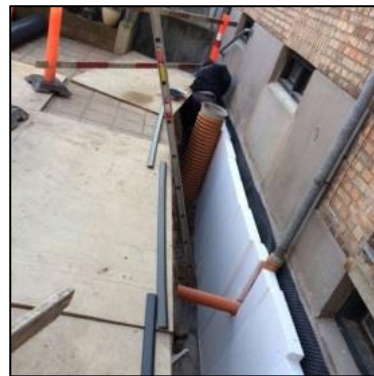
Omfangsdræn i Sandbygård
